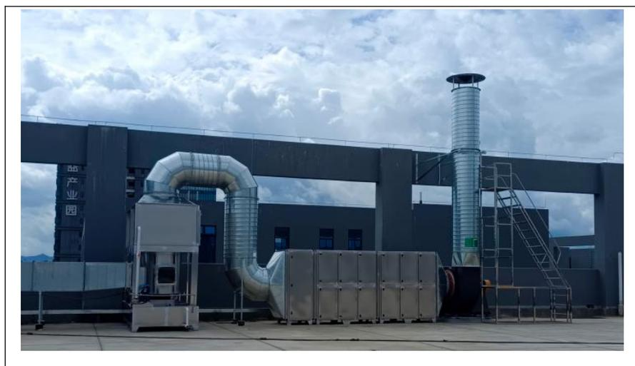
图4.2-1废气收集及治理设施现场图片
